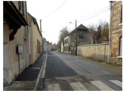
La chaussée était particulièrement dégradée sur le côté sud de la rue de PARIS et les riverains se plaignaient de projections de boue sur les murs par les voitures quand il pleuvait et la sécurité des piétons risquait de ne plus être assurée. Une réfection partielle a été effectuée fin février sur une distance d'environ 150 mètres à partir du carrefour.
